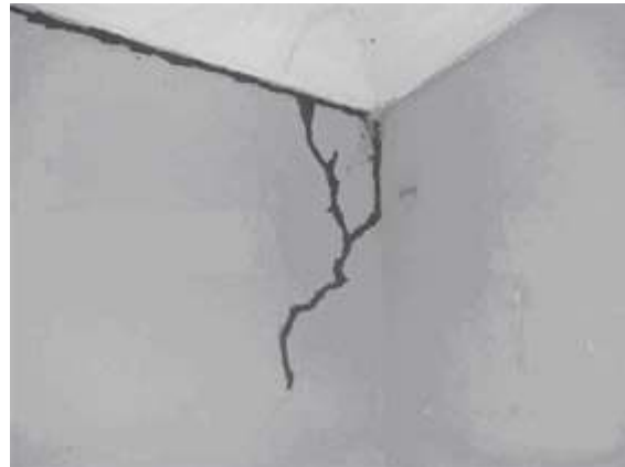
Foto 31: Galería externa descendente desde el techo en habitación.
